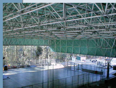
PUERI DOMUS Construção e reformas diversas unidades do Colégio Pueri Domus Aldeia da serra / Verbo Divino / Paineiras
