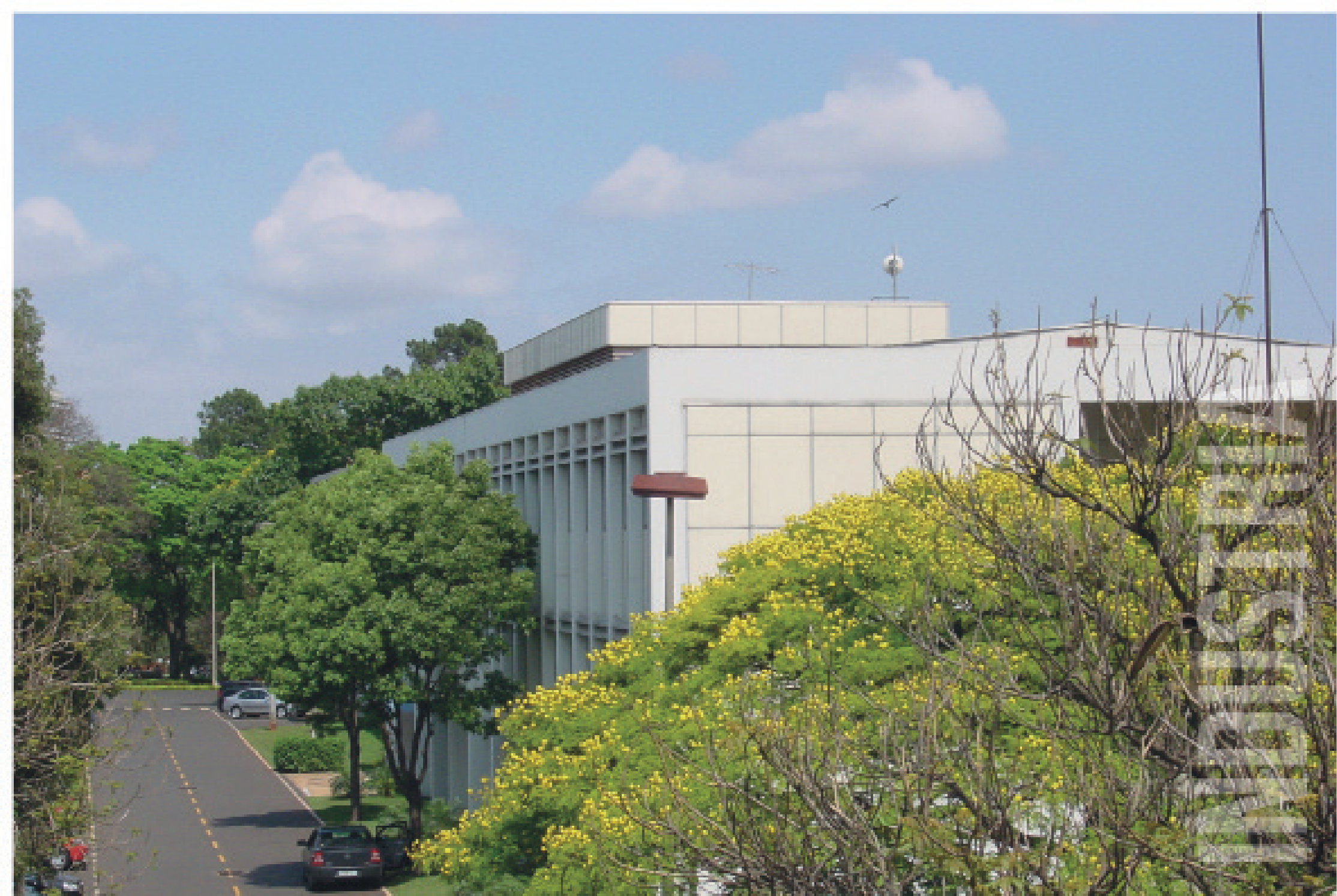
BOSCH CAMPINAS - PRÉDIO DA ENGENHARIA E DIVERSAS OBRAS
